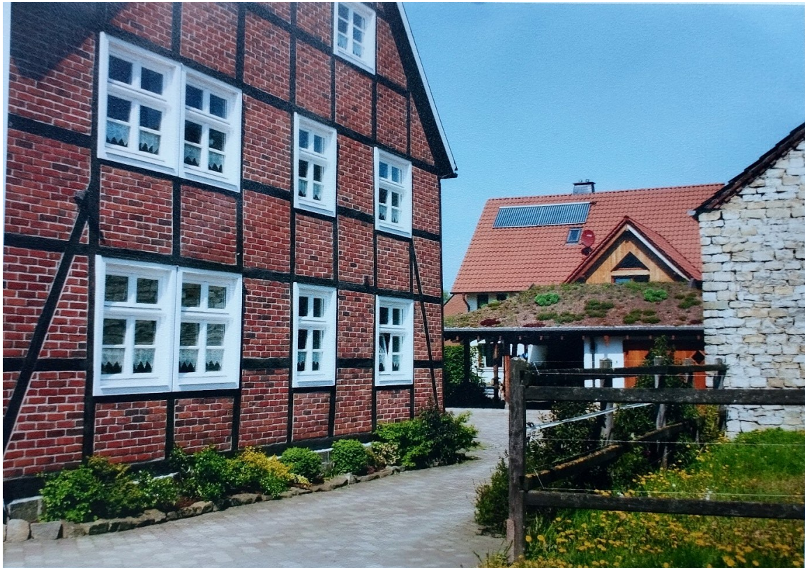
Das wunderbar sanierte Haus Hollenbeck-Koers. Im Hintergrund ist ein neues Gebäude an dem Standort errichtet worden, an dem sonst eine Scheune von Hollenbeck stand. Rechts im Bild eine Bruchsteinscheune des Nachbargrundstücks.
