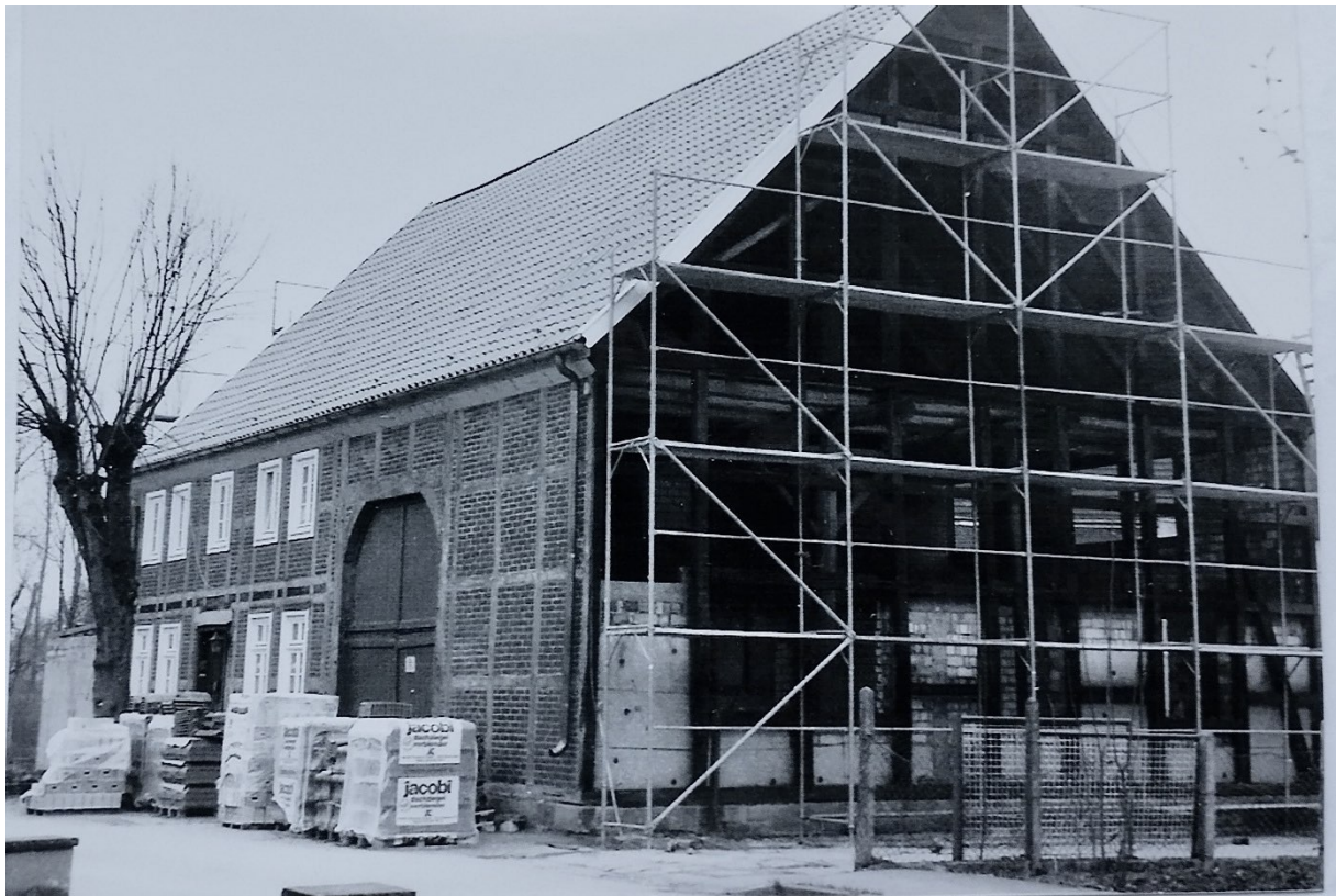
Bei den Umbauarbeiten
