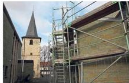
Die Außenmauern sind mit einem Gerüst eingedeckt.
