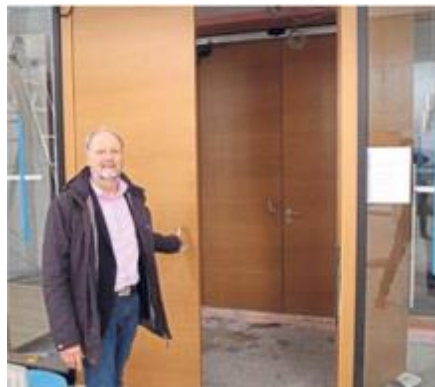
Der neue Eingang mit Elektrotür ist bereits fertig.
