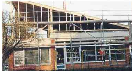
Ein neues Dach erhielt das heutige Gebäude in der Bredendollgasse im Jahr 1992.
